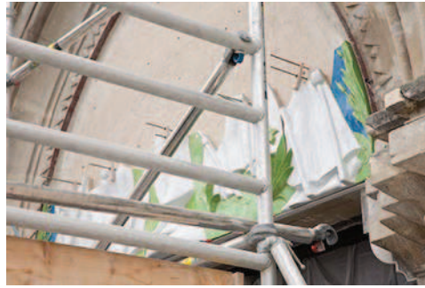
14 Détail installation tympan.jpg
